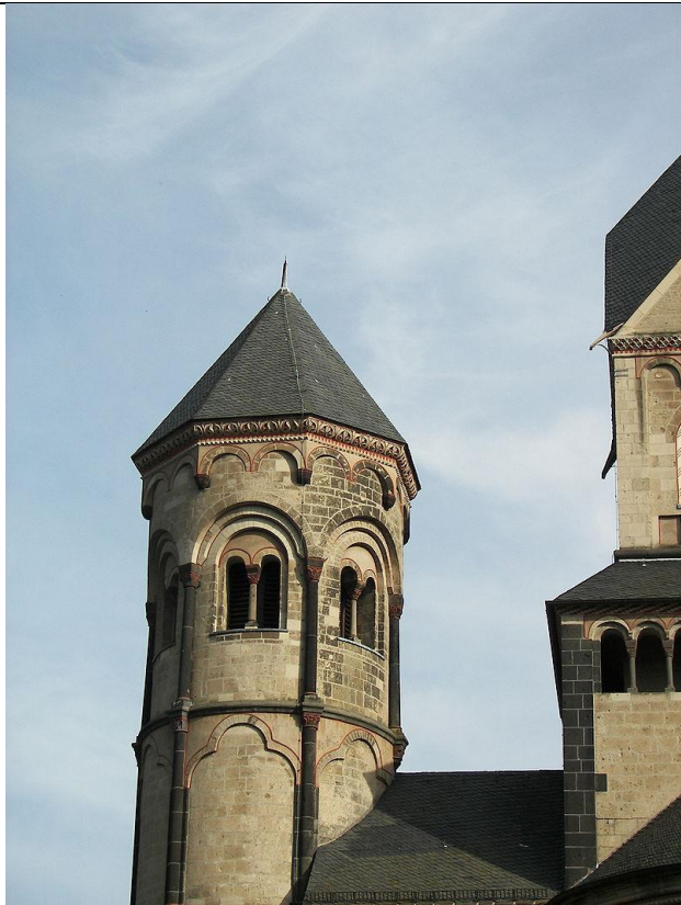
Nördlicher Begleiturm im Westteil
